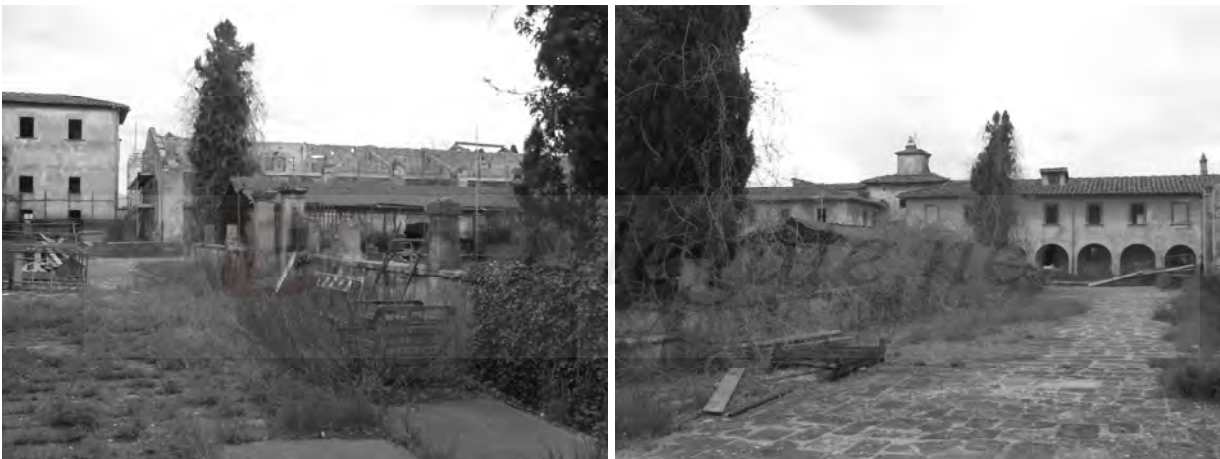
Figg. 18 e 19 - Viste del cortile interno della Cascina
