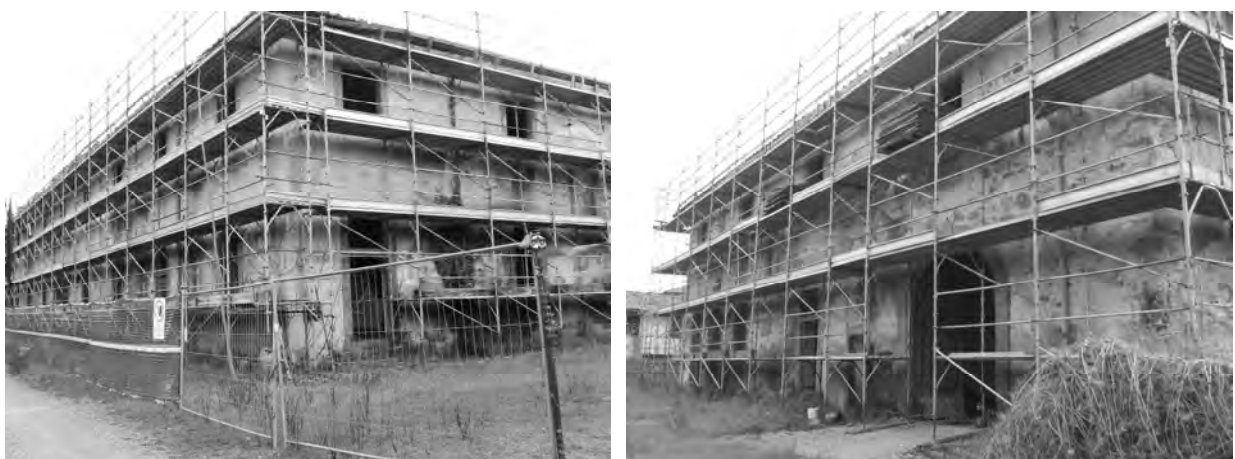
Figg. 20 e 21 - Viste esterne del fabbricato Magazzini e Tinaia
