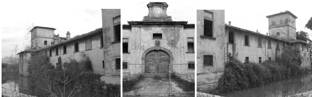
Figg.9, 10, 11 - Viste dell'ingresso, del muro esterno e del fossato della Cascina
