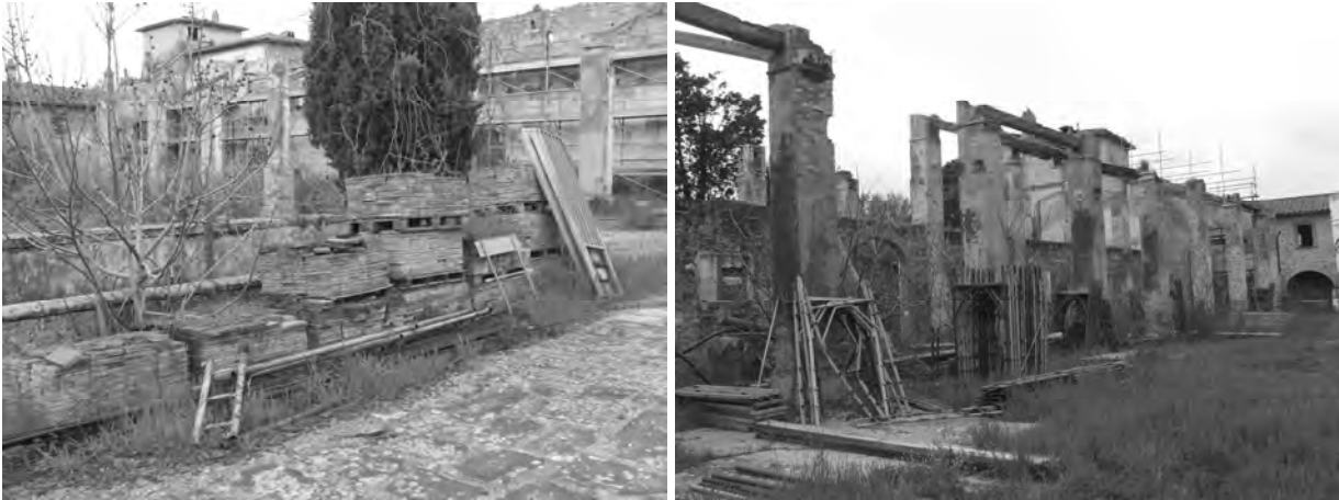
Figg. 16 e 17 - Viste dal cortile interno della Cascina (lato est)
